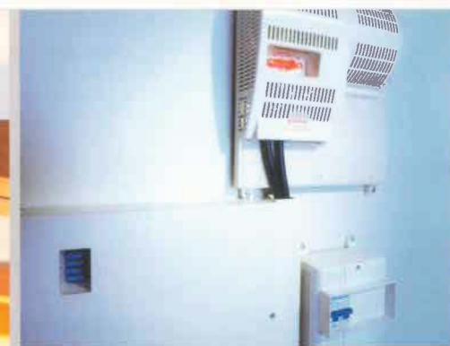
Elektronisch geregelde stroomvoorziening (montagevoorbeeld)
