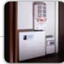
Elektronisch geregelde stroomvoorzie- ning met aard- lekschakelaar
